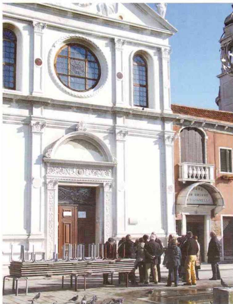
Visita del 7 marzo: Chiesa di Santa Maria della Visitazione, detta dei Gesuati.
