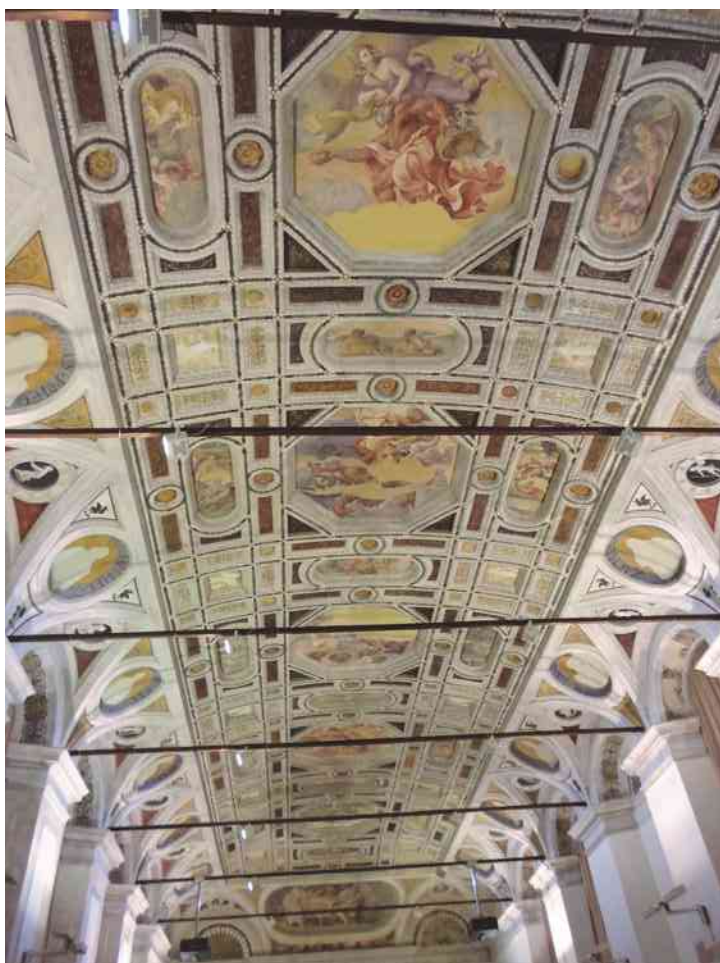
La volta del soffitto del Capitolo di San Salvador dopo il recente restauro.
