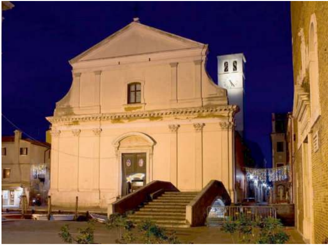
Chioggia - Chiesa dei Filippini
