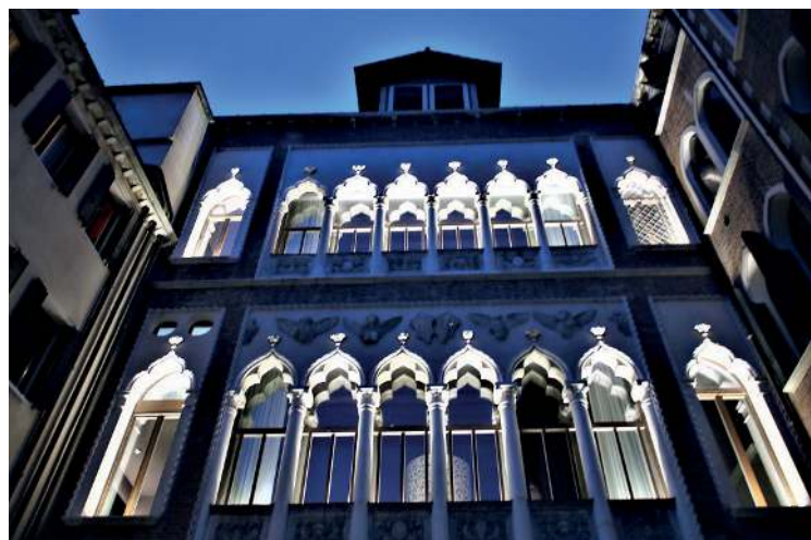
▲ Hotel Centurium - facciata
